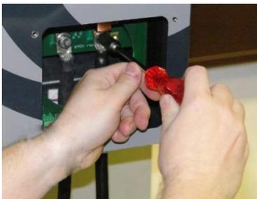
如上图所示：电缆通过右侧开口连接。固定不锈钢 M8 螺丝时，请使用 9 至 10 Nm 的扭矩。熔断器位于左侧罩盖的后面。
