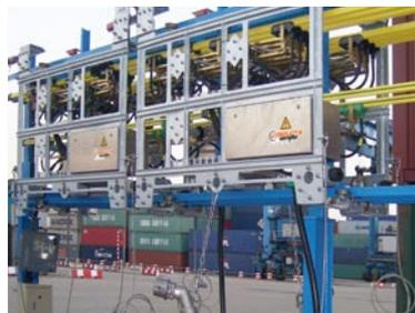
手动集电器小车,包括连接到轮胎龙门吊的电缆和插头。插座连接器装在龙门吊的侧面。
