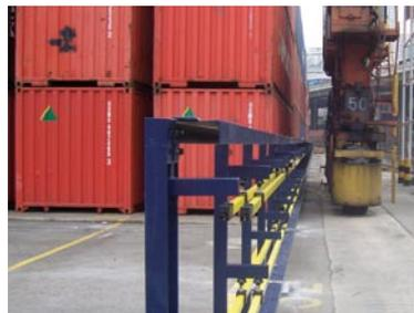
用于一台轮胎龙门吊油改电方案的滑触线和钢结构支架。
